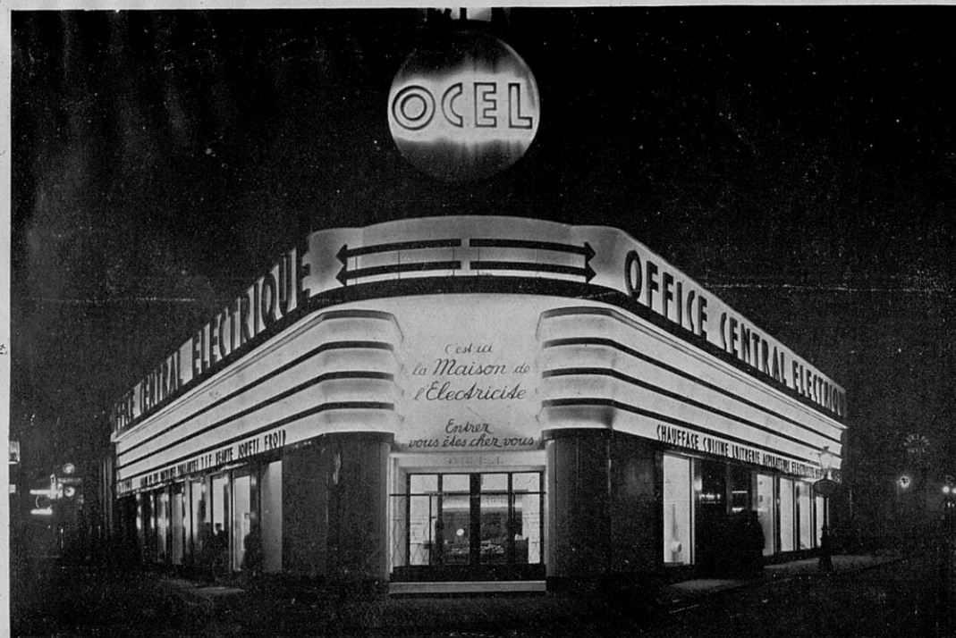
L'OFFICE CENTRAL ÉLECTRIQUE ARCHITECTES : A. LAPRADE ET L. BAZIN ÉCLAIRAGE INDIRECT DE LA FACADE RÉALISÉ PAR PAZ ET SILVA, ÉLECTRICIENS DÉCORATEURS A L'AIDE DE TUBES AU NEON BLEUS ET ROUGES MASQUÉS DANS L'INTÉRIEUR DES GORGES.
