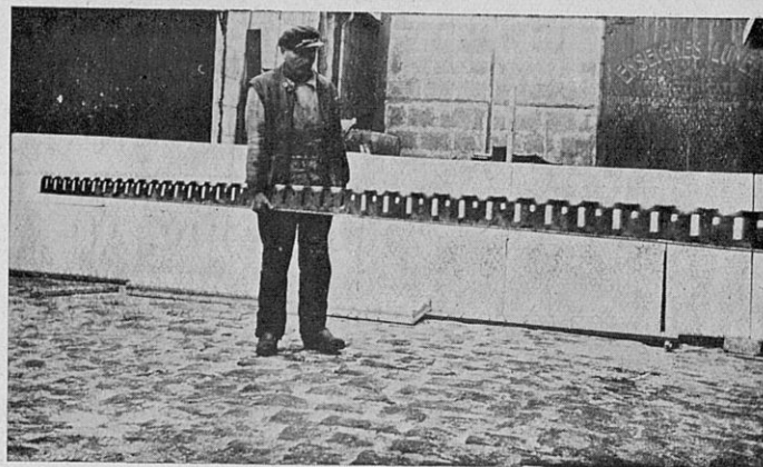
FIG. 1 — LA NOUVELLE POUTRELLE CRÉNELÉE
