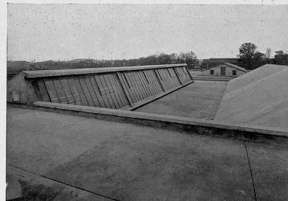
Biscuiterie Heudebert-Architectes MM. Labussière et Reby Toitures-Terrasses, système Ythier
