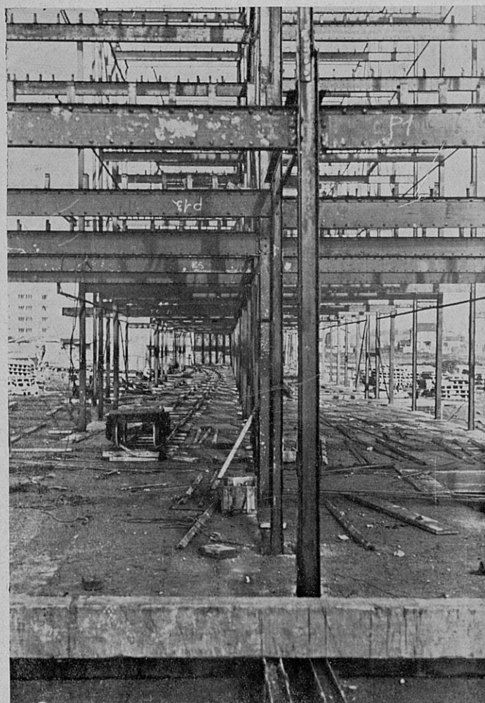
CHARPENTE MÉTALLIQUE A REZ-DE-CHAUSSÉE
