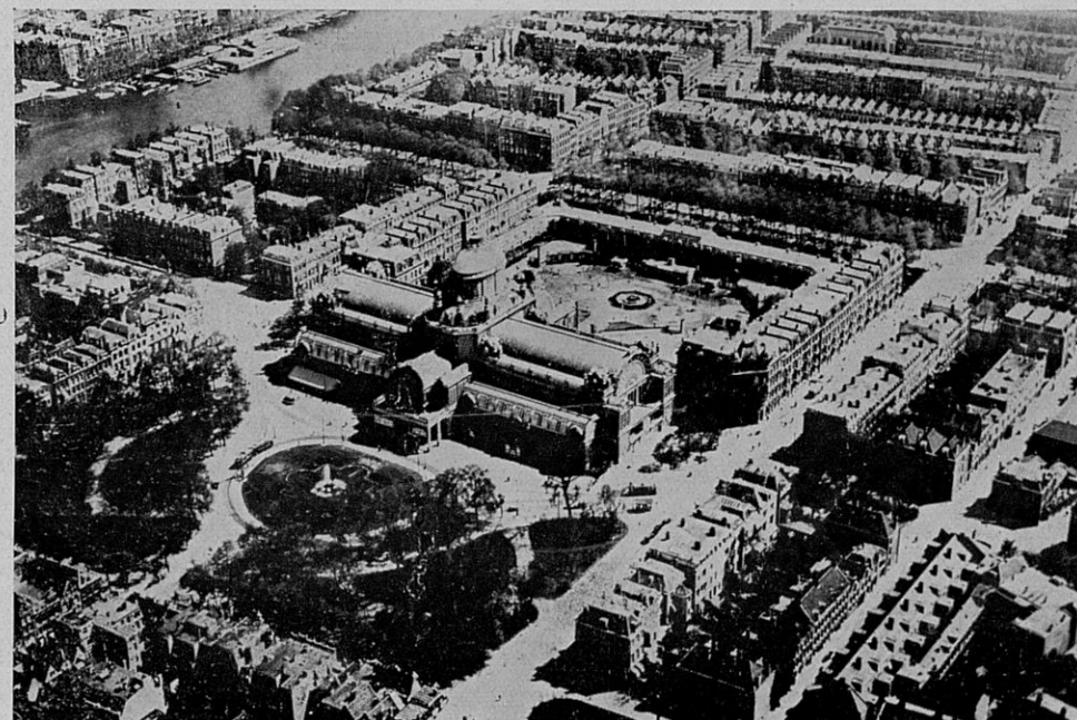
VUE A VOL D'OISEAU DU PALAIS DES ARTS ET MÉTIERS, (ARCH. OUSHOORN), CENTRE DU QUARTIER, FONDÉ DÈS 1863 PAR L'INITIATIVE DU Dr SARPHATI. LE PALAIS FUT TOTALEMENT DÉTRUIT PAR UN INCENDIE EN 1929. Photo K. L. M.
