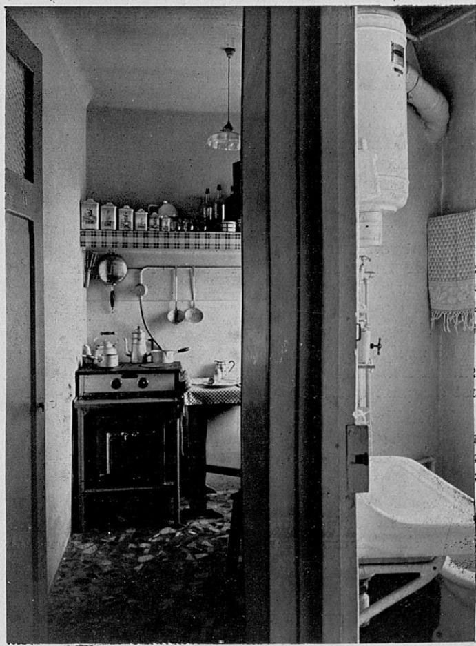
INSTALLATION MIXTE: CUISINE ET CABINET DE TOILETTE ALIMENTÉS PAR UN CHAUFFE-EAU ÉLECTRIQUE
