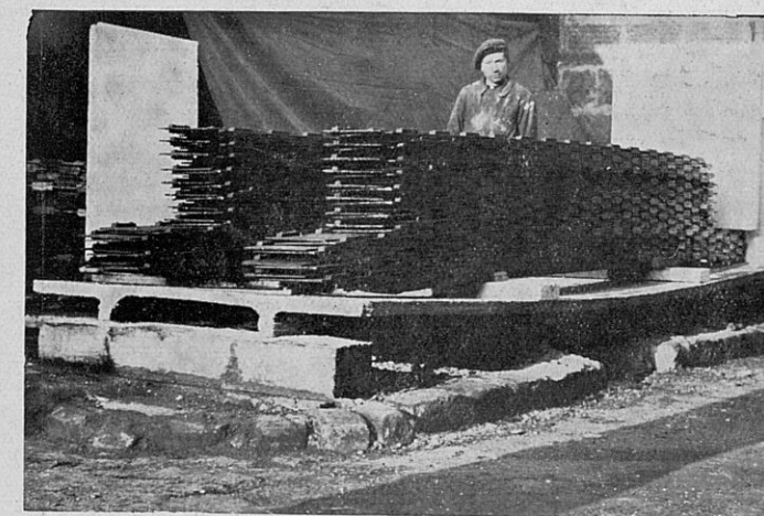
Fig. 6 — ESSAI DE CHARGE. Toute la charge est concentrée sur les deux points placés à 1 m. 20 des appuis de façon à laisser libre toute la surface du hourdis en béton et à provoquer son décollement des poutrelles. Après 3 mois d'essai, on n'a constaté aucun décollement.
