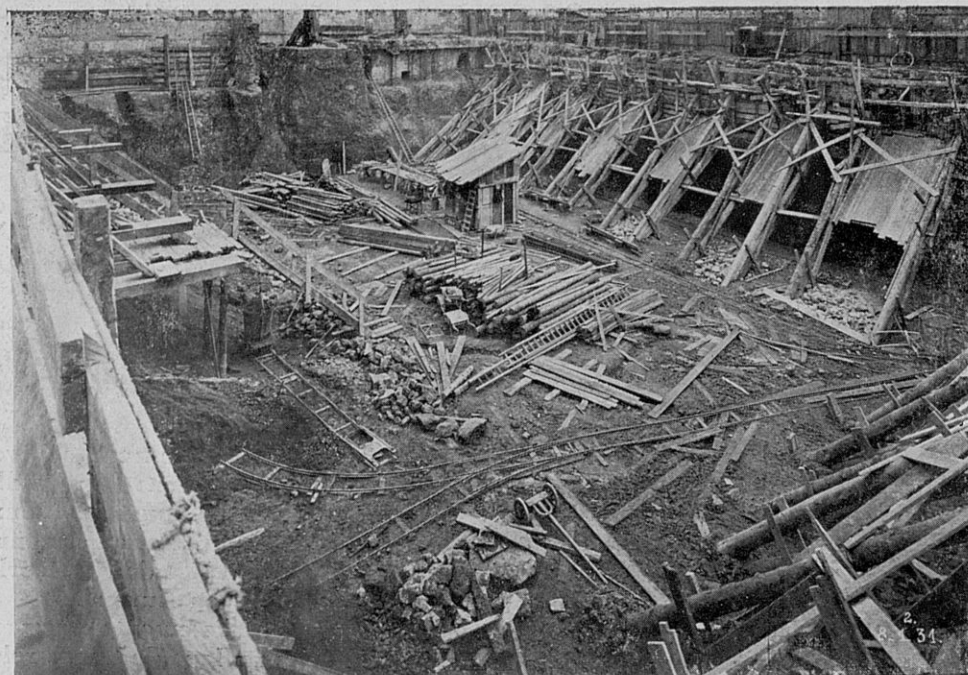
FOUILLES, SOUTÈNEMENT DES TERRES 8 Janvier 1931
