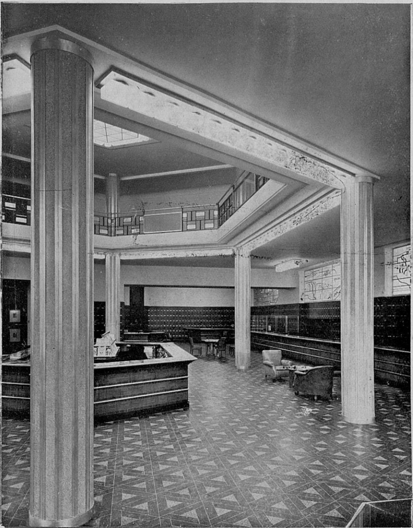
LA MAISON DE FRANCE : GRAND HALL DU PUBLIC S'ÉLEVANT SUR DEUX ÉTAGES
