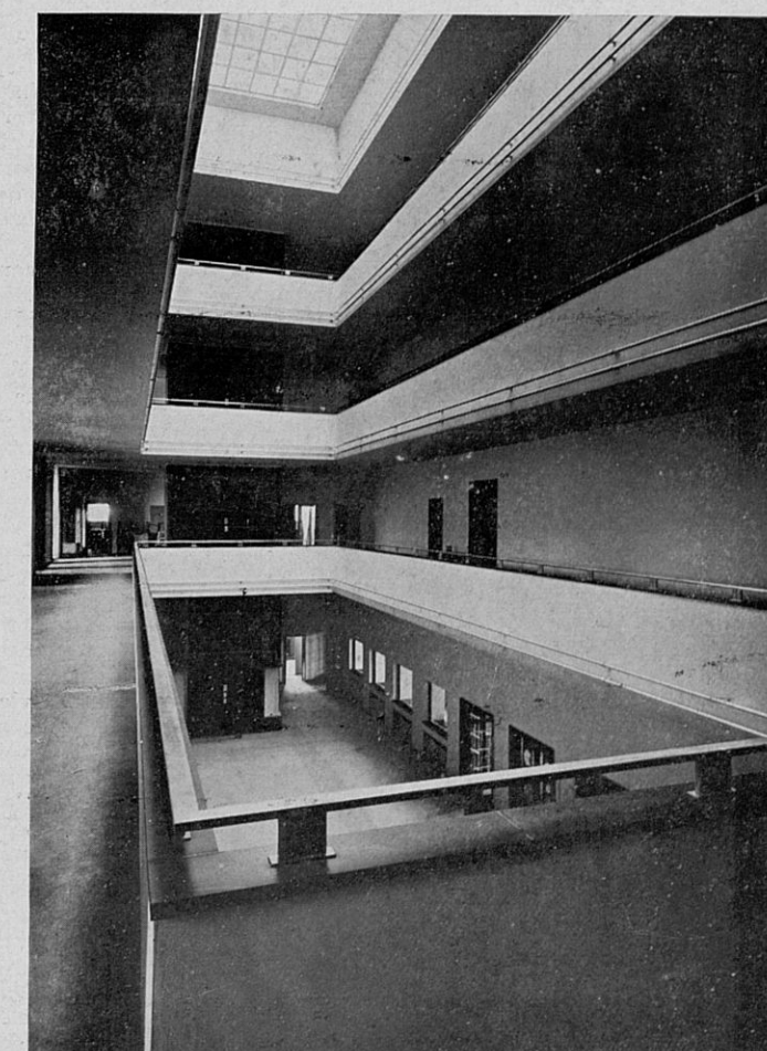
A REMARQUER LES TUBES CHROMÉS DE CHAUFFAGE ACCROCHÉS AUX BALUSTRADES DES GALERIES
