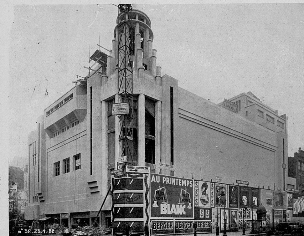
ETAT DE LA CONSTRUCTION RAVALEMENTS TERMINÉS LE 23 / 1 / 32 FAÇADE SUR RUE ET BLD. POISSONNIÈRE
