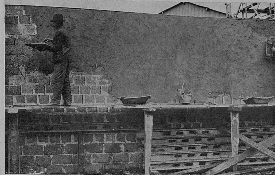
APPLICATION FACILE DE L'ENDUIT
