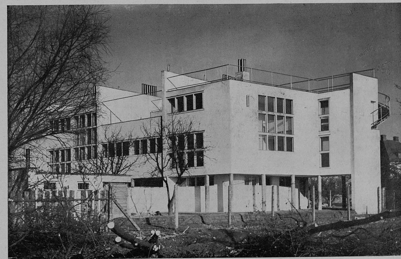
MAISON POUR 3 FAMILLES A SASKA KETA (VARSOVIE) CONSTRuite EN BÉTON CELLULAIRE (CELLOLITE)
