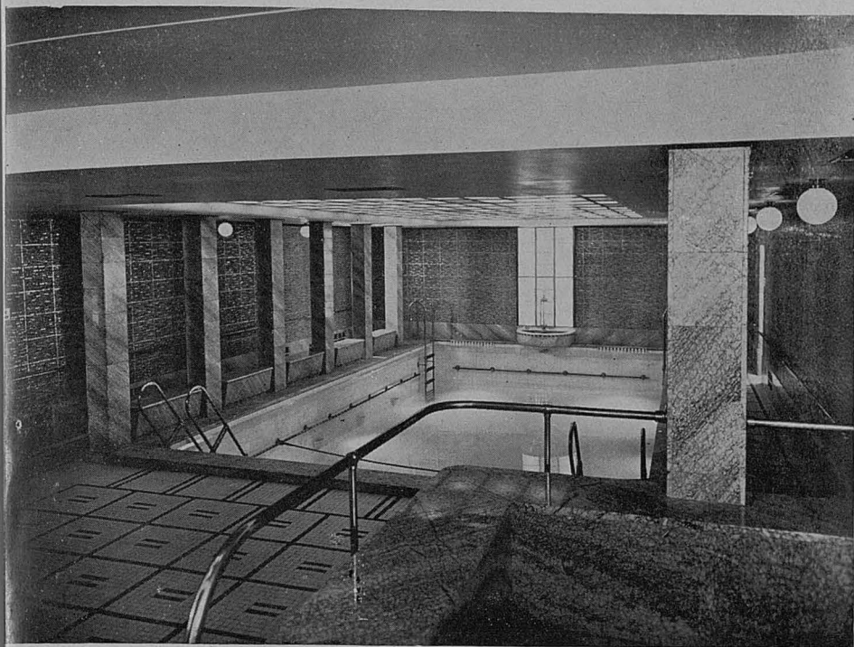
PISCINE DU BREMEN: ARMATURES DU PLAFOND VITRÉ, SUPPORTS DE LAMPES, BARRES D'APPUI, ESCALIERS, ECHELLES EN MÉTAL MONEL RÉSISTANT A L'EAU DE MER
