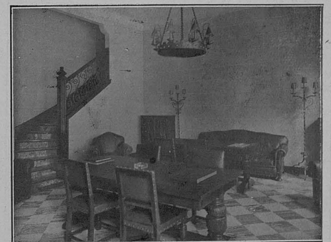
Cité de l'architecture & du patrimoine Tapis de Caoutchouc Beldam-Latty BIBLIOTHÈQUE
