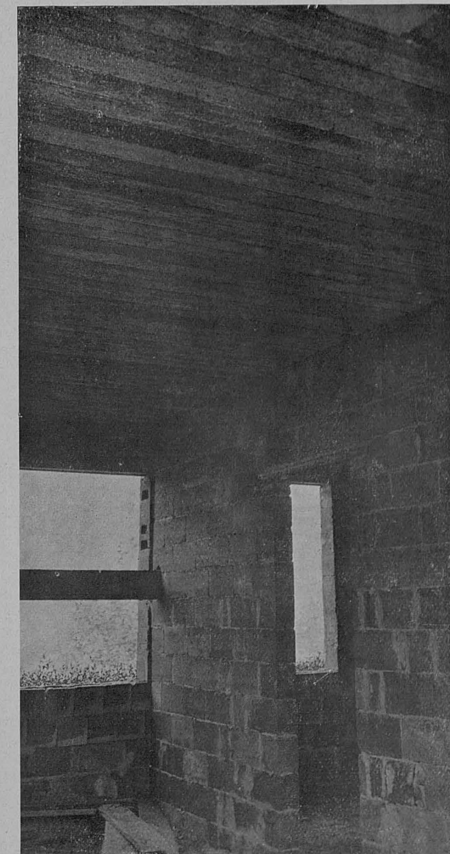
SUPPRESSION DU COFFRAGE ET DU FERRAILAGE VUE INTERIEURE DU PLAFOND-PLANCHER BIBLIOTHEQUE
