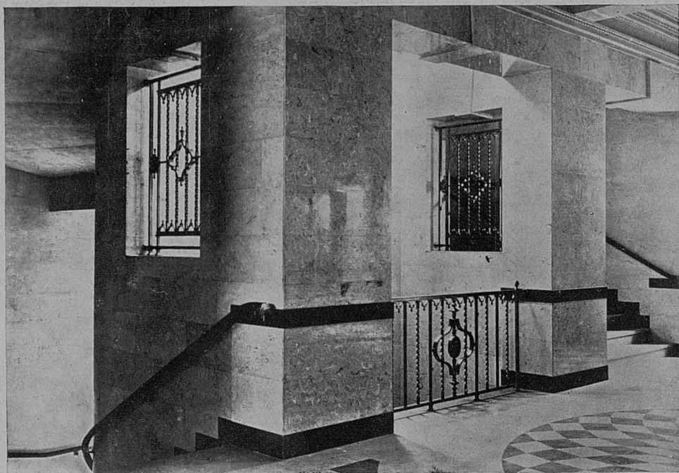
FERRONNERIE EN SILVEROID DANS UN ESCALIER
