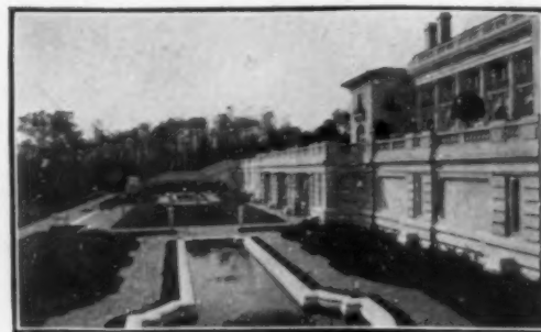
Concrete Residence, Roslyn, L. I., N. Y.
