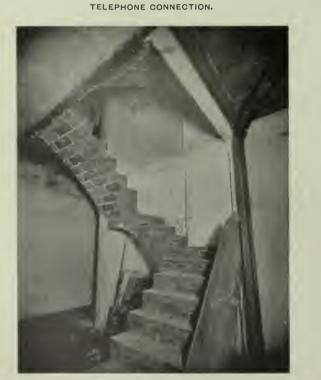
AN EIGHT-STORY HOTEL STAIRCASE IN AN OPEN SHAFT; NO WALLS. CONSTRUCTION LEFT READY TO RECEIVE MARBLE FINISH.
