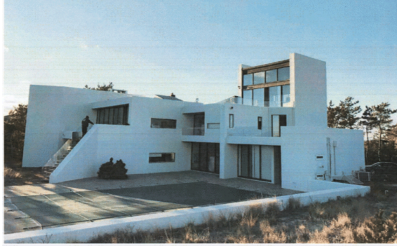
1) EXISTING EXTERIOR VIEW—LOOKING SOUTH SCALE: N.T.S.
