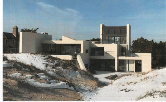
3) EXISTING EXTERIOR VIEW—LOOKING NORTH SCALE: N.T.S.
