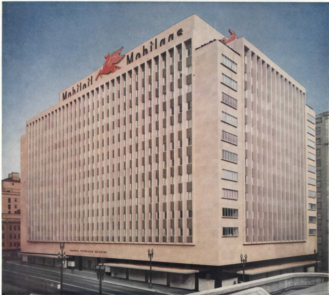
Wurdeman & Becket, Architects; P. J. Walker Co., Builders
