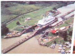
▶ Panama Canal, Panama
