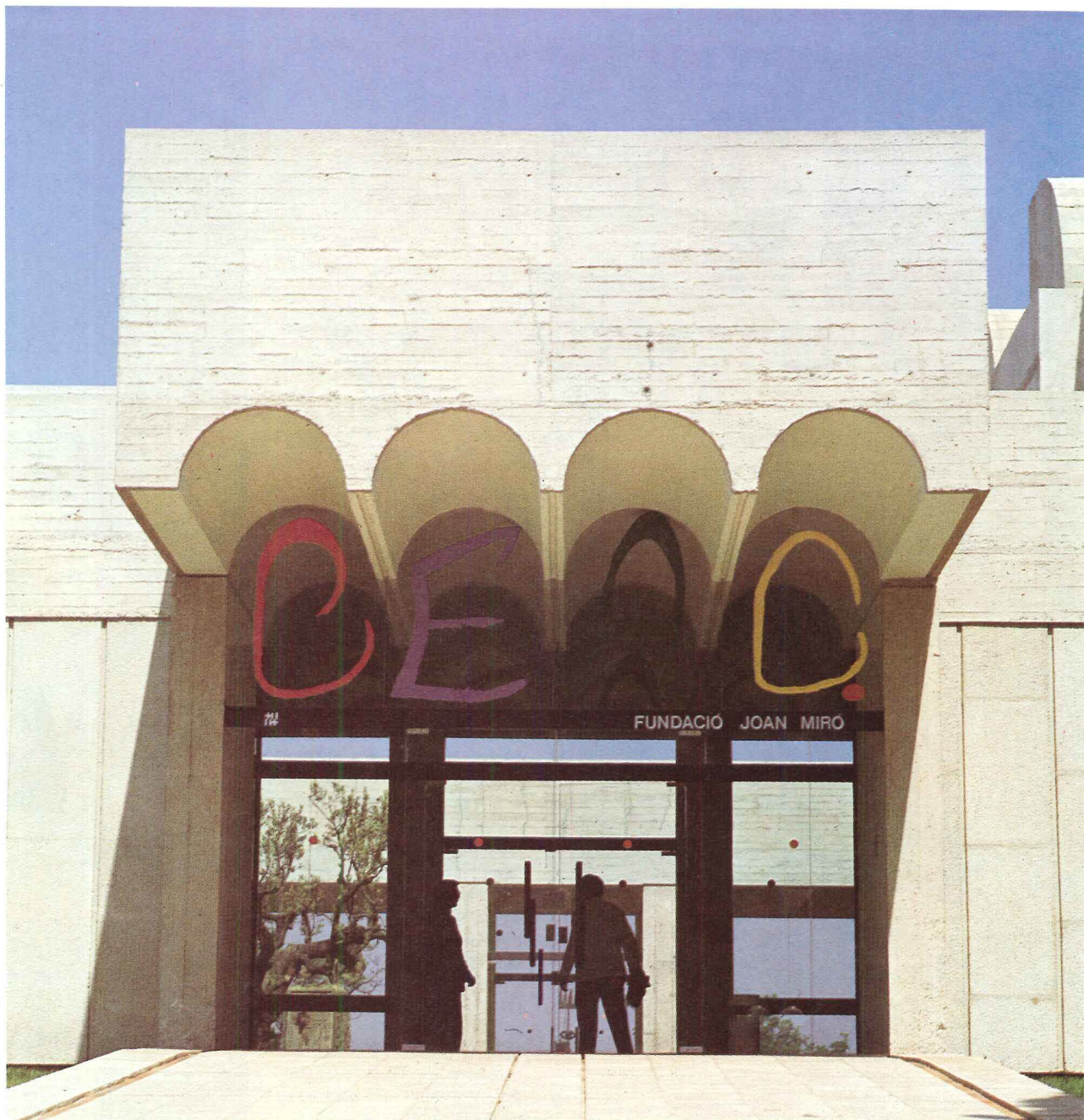
F. Catalá Roca photos
