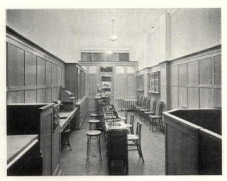
SPECIAL INDIRECT AND DIFFUSED LIGHTING IS REQUIRED FOR THE OPTICAL STORE. A SIMPLE FORM OF INDIRECT LUMINAIRE IS SHOWN HERE.
