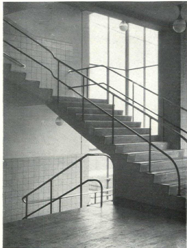
Van Nelle Factory, Rotterdam, Holland J. A. Brinkman & L. C. van der Vlugt
