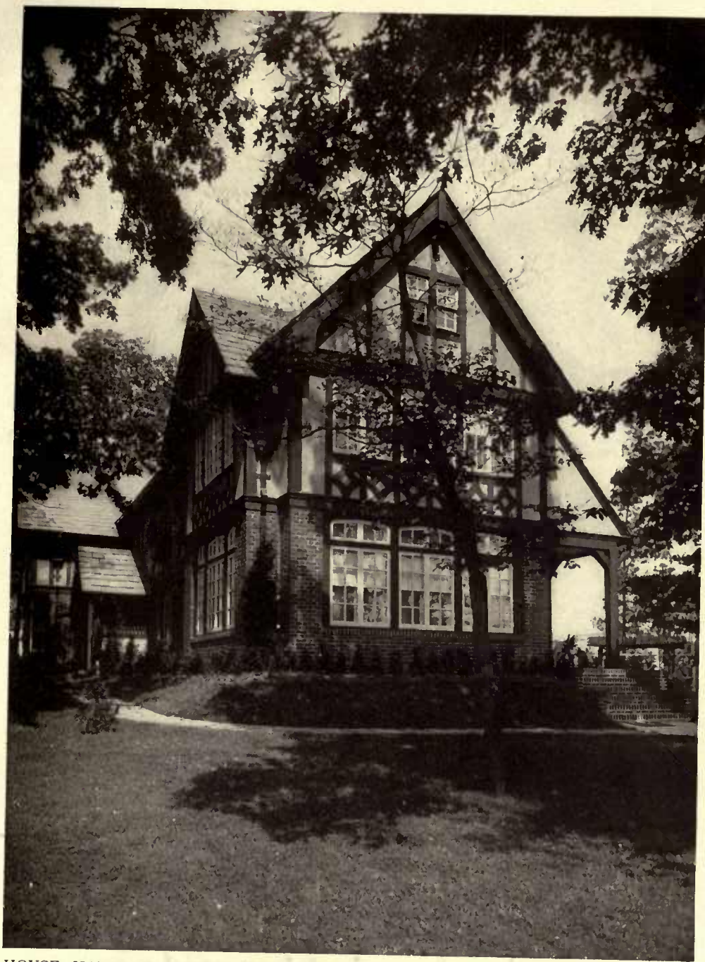
HOUSE, HARRY F. WEBER, MT. VERNON, N. Y.
