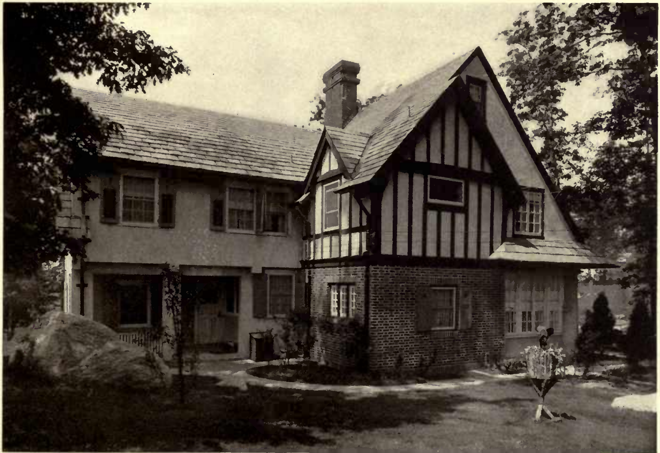
HOUSE, HARRY F. WEBER, MT. VERNON, N. Y.
