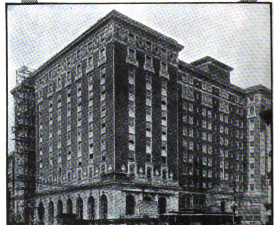
Pantlind Hotel, Grand Rapids, Mich. Gen. Con.: Fuller Construction Co., N. Y. C. Rfg. Con.: M. W. Powell Co., Chicago, Ill. Waterproofing Con.: Tuttle Rfg. Co., N. Y. C.
