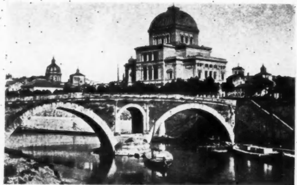
Fig. 16. Ponte Quattro Capi, Rome
