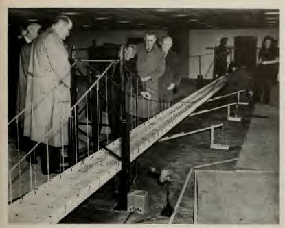
WIND-TUNNEL TEST MODEL
