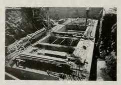
PYLON BASE 132 FEET LONG, 32 FEET WIDE COMPLETED PYLON WILL BE 230 FEET HIGH
