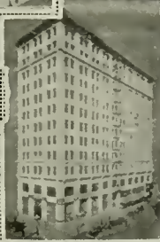
HAAS BLDG. LOS ANGELES, CAL.
