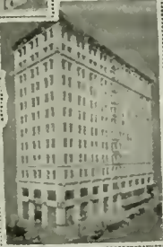
HAAS BLDG. LOS ANGELES CAL.
