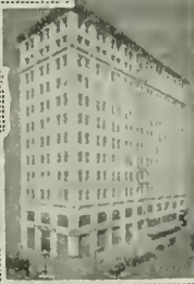
HAAS BLDG. LOS ANGELES, CAL.
