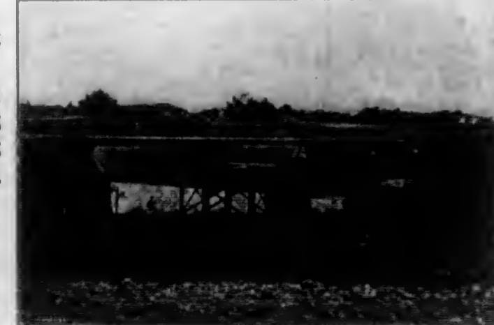
Bridge in Berzdorf, I. S.
