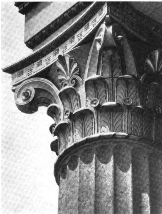
POLYCHROME TERRA COTTA CAP
