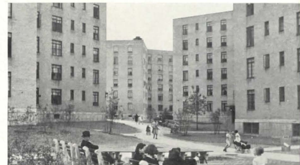
Queensbridge Houses, New York; W. F. R. Ballard, H. S. Churchill, F. G. Frost, B. C. Turner, Archts.
