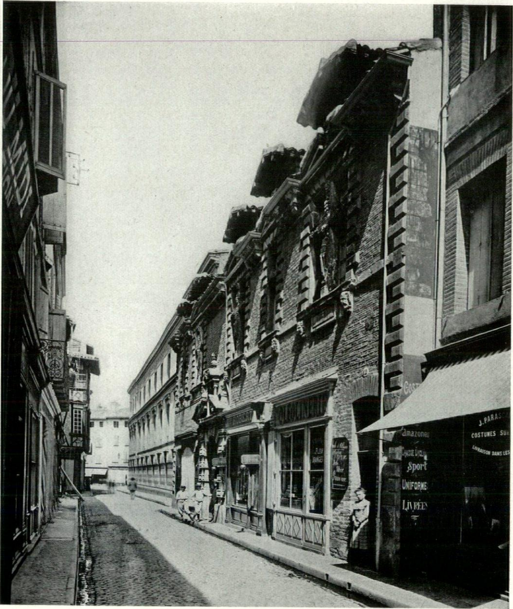
MAISON DE GUISE IN RUE TIMBAL, ALBI, FRANCE
