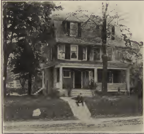
Fig. 18. An Average House. New Rochelle, N. Y. J. N. S. Quoi, Architect.
