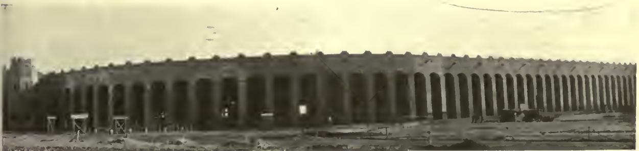
EXTERIOR, PALMER STADIUM, PRINCETON, N. J.
