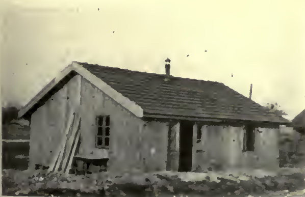
A COMPLETED BARRACK, HOME CITÉ DE LA SOCIÉTÉ DES AMIS, MEUSE
