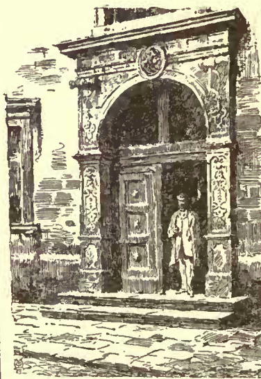
Doorway at Dentzic. From Architektonische Rundschau .
