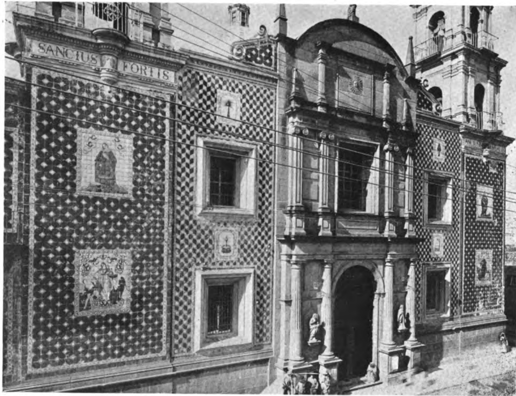
SANTUARIO DE LA LUZ, PUEBLA, STATE OF PUEBLA: DETAIL OF THE FAÇADE
