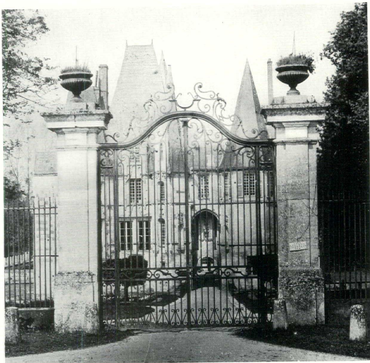
Entrance Gates, Chateau D'O
