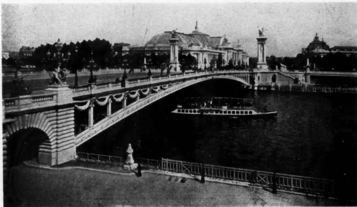
Fig. 9. Pont Alexandre III, Paris
