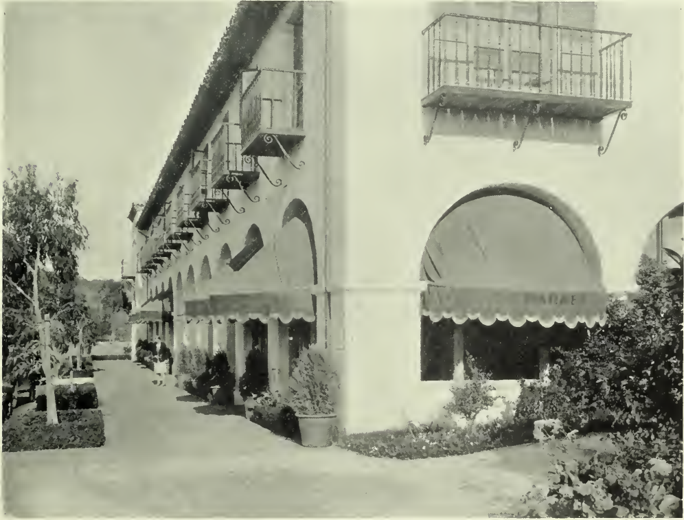
THE VIA CORTA CORNER OF CASA PRIMERA, PALOS VERDES ESTATES
