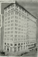
HAAS BLDG. LOS ANGELES CAL.
