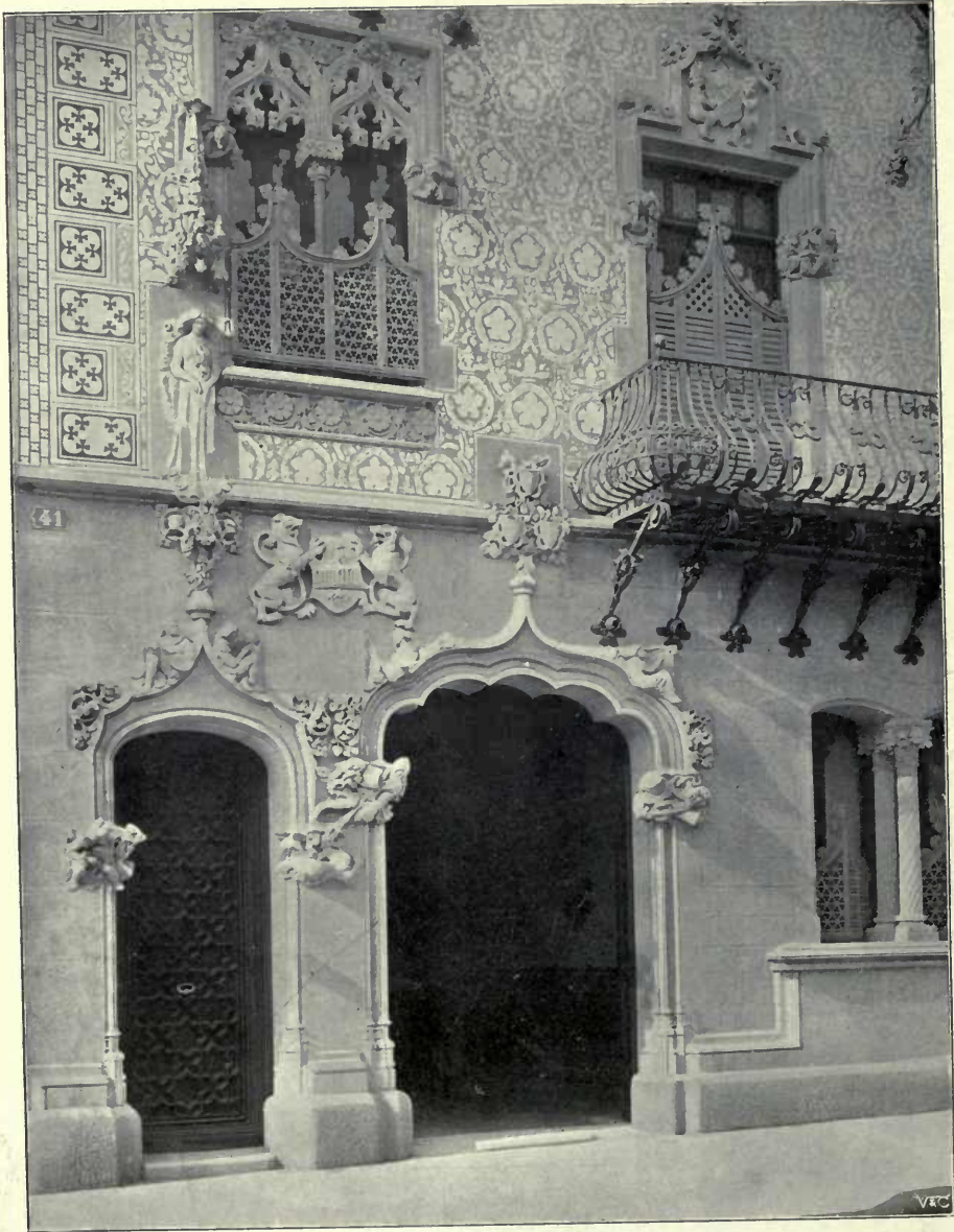
Maison Amatller, Detail of Façade, J. PUIG Y CADAFALCH, Architect, Barcelona.
